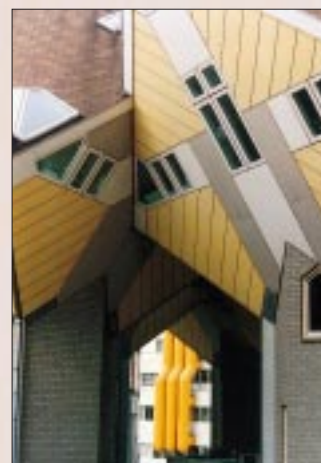
Cempanel als gevelbekleding op de kubuswoningen van architect Piet Blom in Rotterdam.
