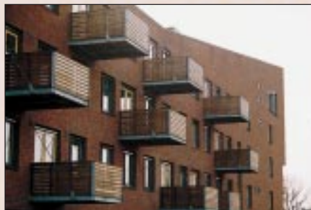
Project Het Fort in Apeldoorn heeft balkons van plathout, geleverd door Fetim.
