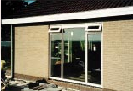
Kapla moet het aloude, al in de ruwbouwfase geplaatste inmetsekozijn gaan vervangen.
