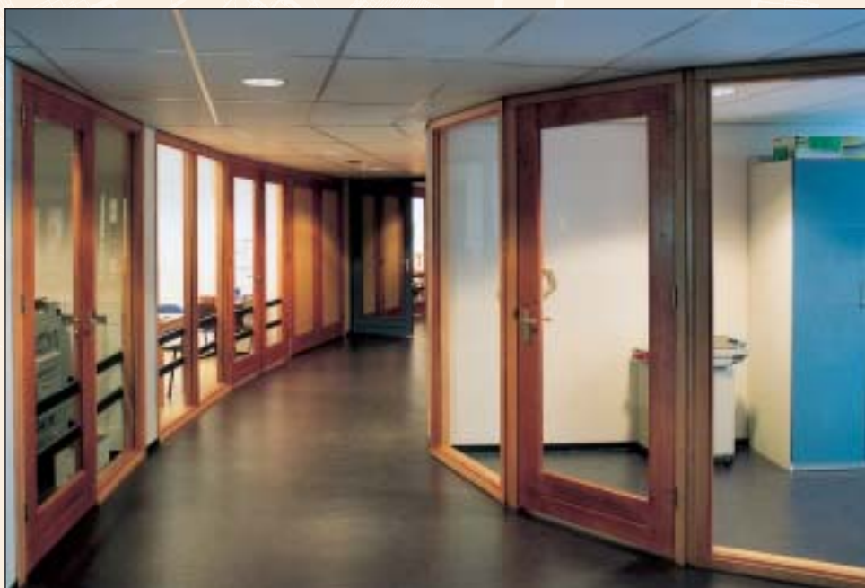
▽ Alle muren langs de ronde middengang bestaan uit houten elementen dan wel deuren met glas of triplex.
