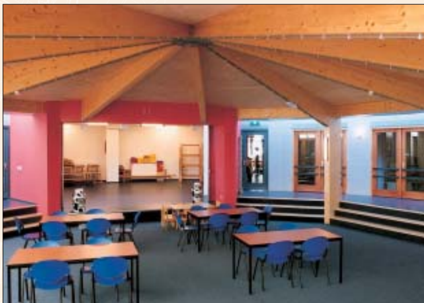
▽ Alle muren langs de ronde middengang bestaan uit houten elementen dan wel deuren met glas of triplex.
