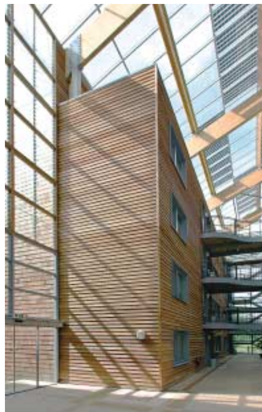
Het vierlaagse bouwdeel garantwoningen steekt deels het atrium in, shingles worden hier, brandvertragend behandeld, potdekselwerk.
