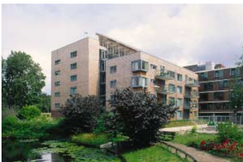
Zicht op het linkerdeel van de nieuwe Waterhof: een vier- en zeslaags bouwdeel, doorsneden door een atrium. Rechts de oude Waterhof, een vijflaags flatgebouw, dat op dit moment wordt gerenoveerd.
