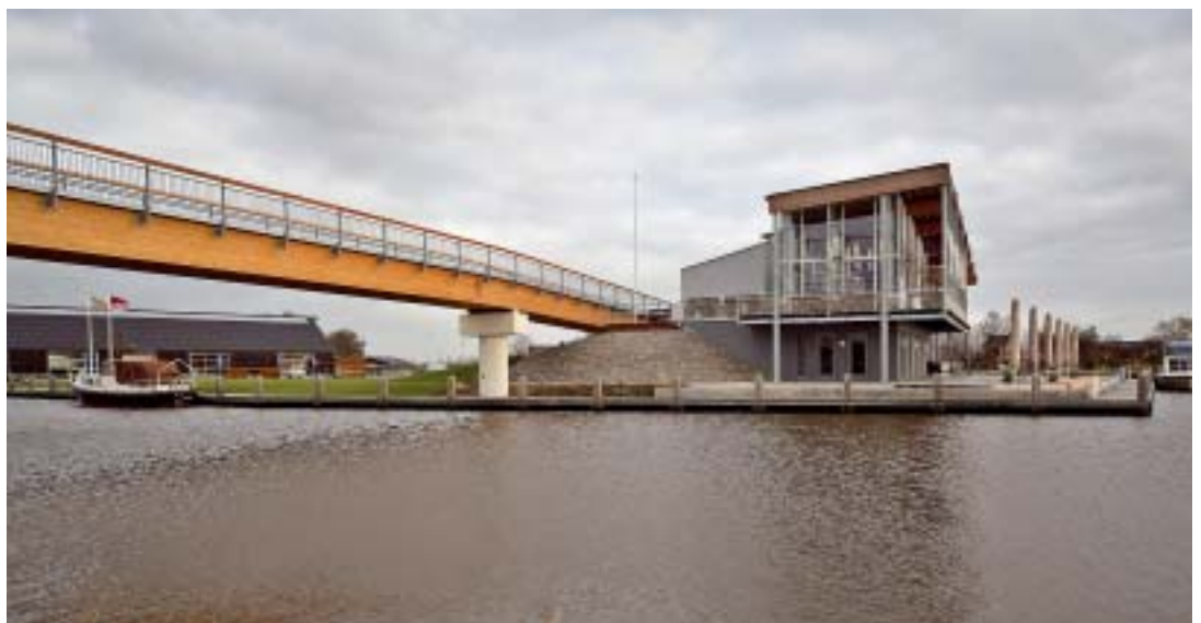
De brug komt uit bij de eerste verdieping van uitspanning Marnemoende, waar ook het restaurant is.
