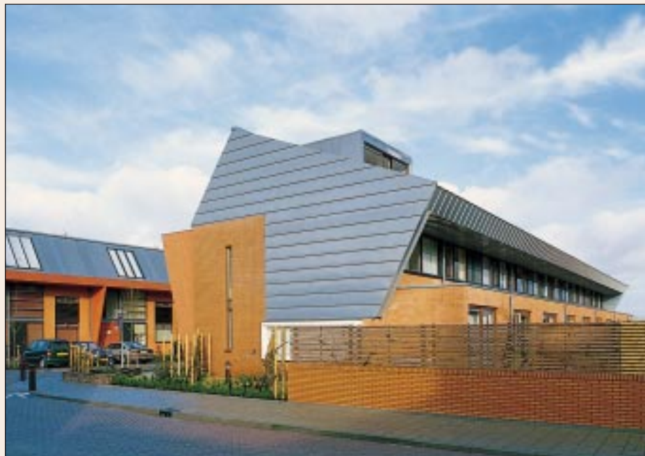
△ Huifwoningen. De kopgevels vertonen een krachtig beeld van zink, baksteen en hout. Een tuinafscheiding in baksteen en gewolmaniseerde vuren lamellen vervolmaken het aanzicht.
