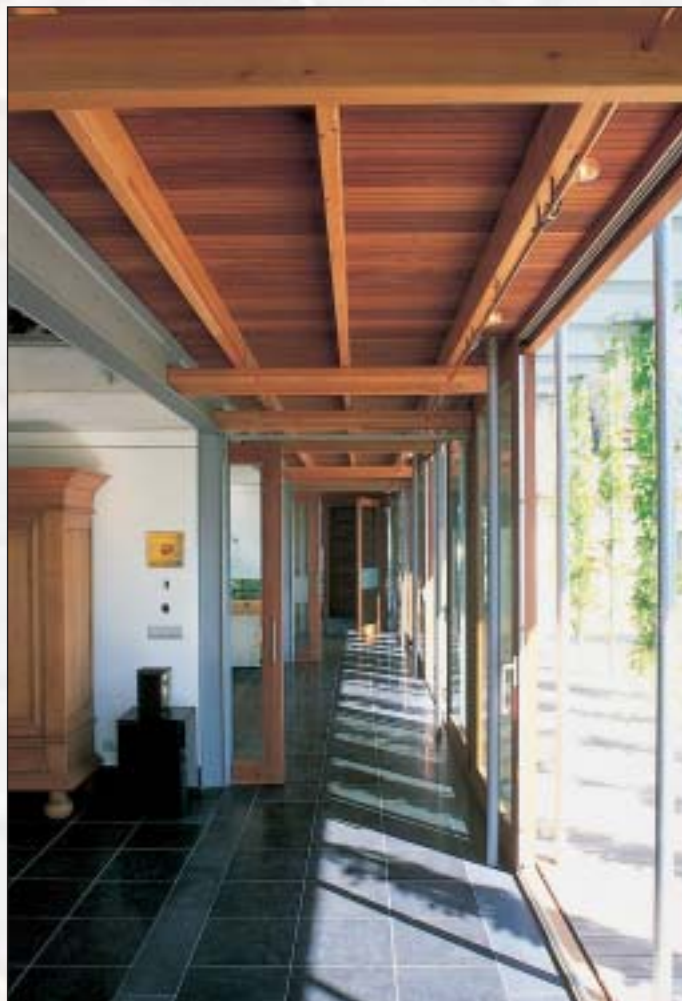
△ Bovenverdieping met iroko deuren en zonnelouvres. Het dak wordt gedragen door liggers en gordingen van Siberisch lariks.
