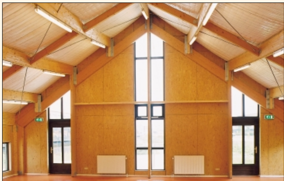
▽ Om de hoge zijgevels zo transparant mogelijk te maken werd direct achter de glasgevel een extra aantal kolommen toegevoegd, waardoor de liggers direct achter het glas smaller konden worden dan in de rest van het bouw- werk.
