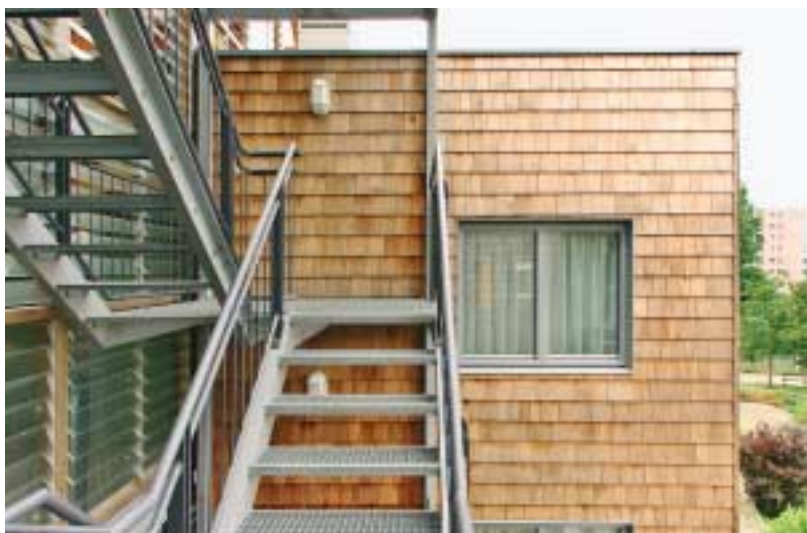
De buitengevels van de garantwoningen zijn bekleed met western red cedar shingles in wisselende breedtes, die door hun schuchter lichtbruine kleur een gevoel van prilheid oproepen. Links een deel met glazen lamellen.
