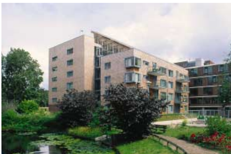
Zicht op het linkerdeel van de nieuwe Waterhof: een vier- en zeslaags bouwdeel, doorsneden door een atrium. Rechts de oude Waterhof, een vijflaags flatgebouw, dat op dit moment wordt gerenoveerd.
