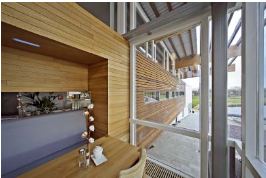
De horizontale gevelbekleding van cumaru loopt van binnen naar buiten door.
