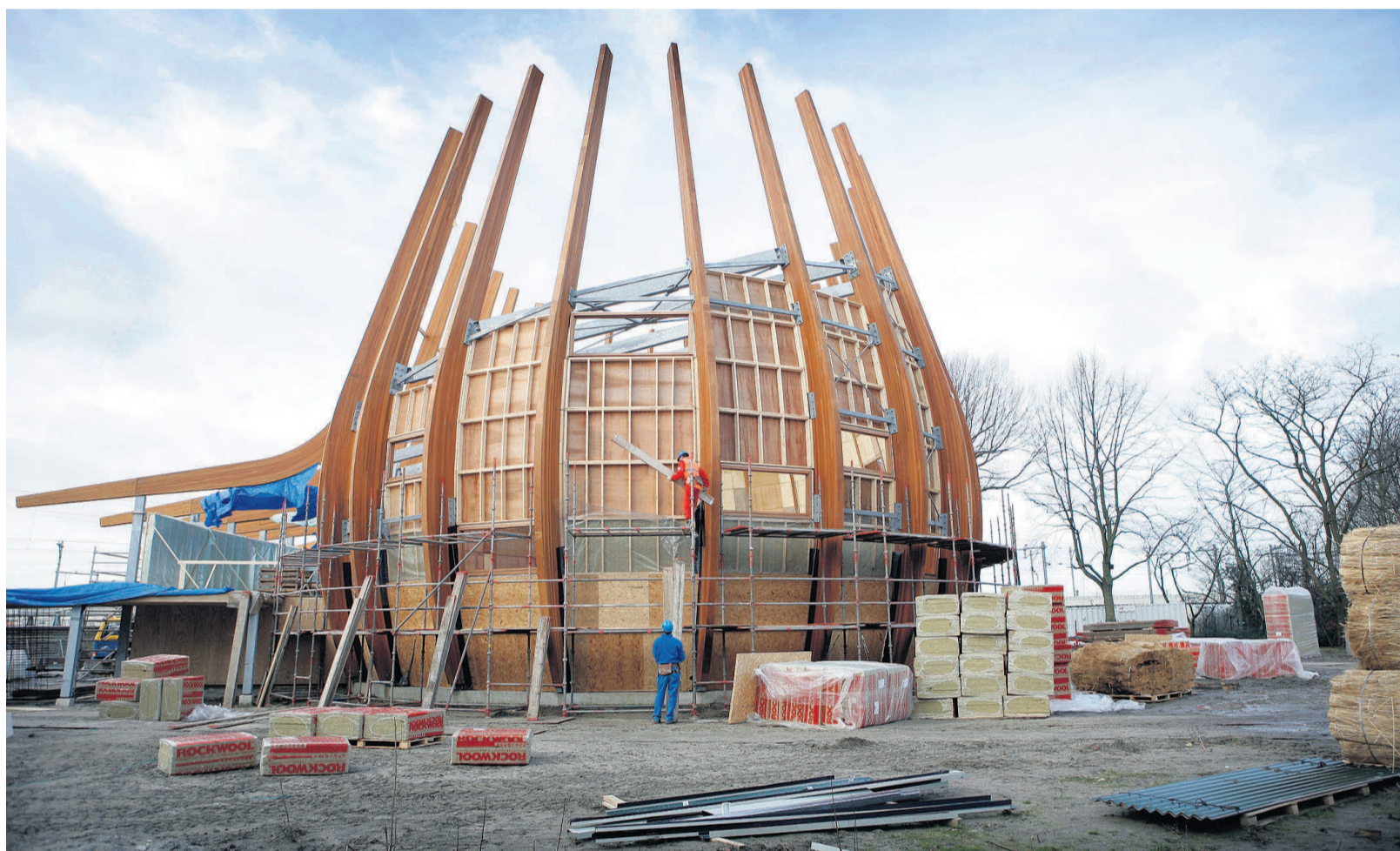
Dura Vermeer bouwt het uivormige giraffeverblijf. Foto: Roel Dijkstra/Joep van der Pal
