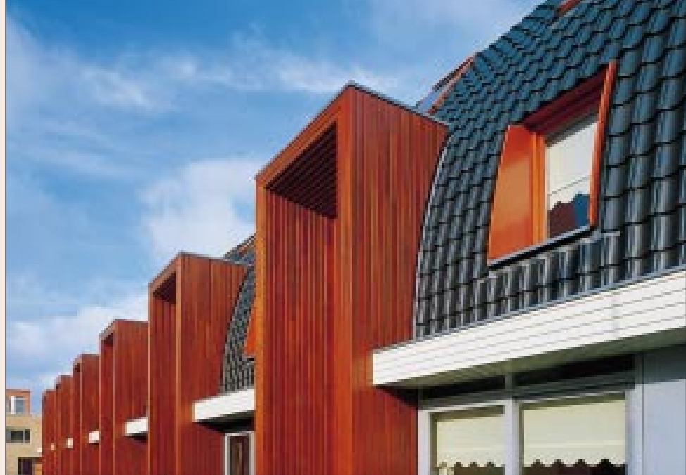
△ De iroko poorten zijn een welkome verademing bij de goeddeels zwarte pannenwoningen.
